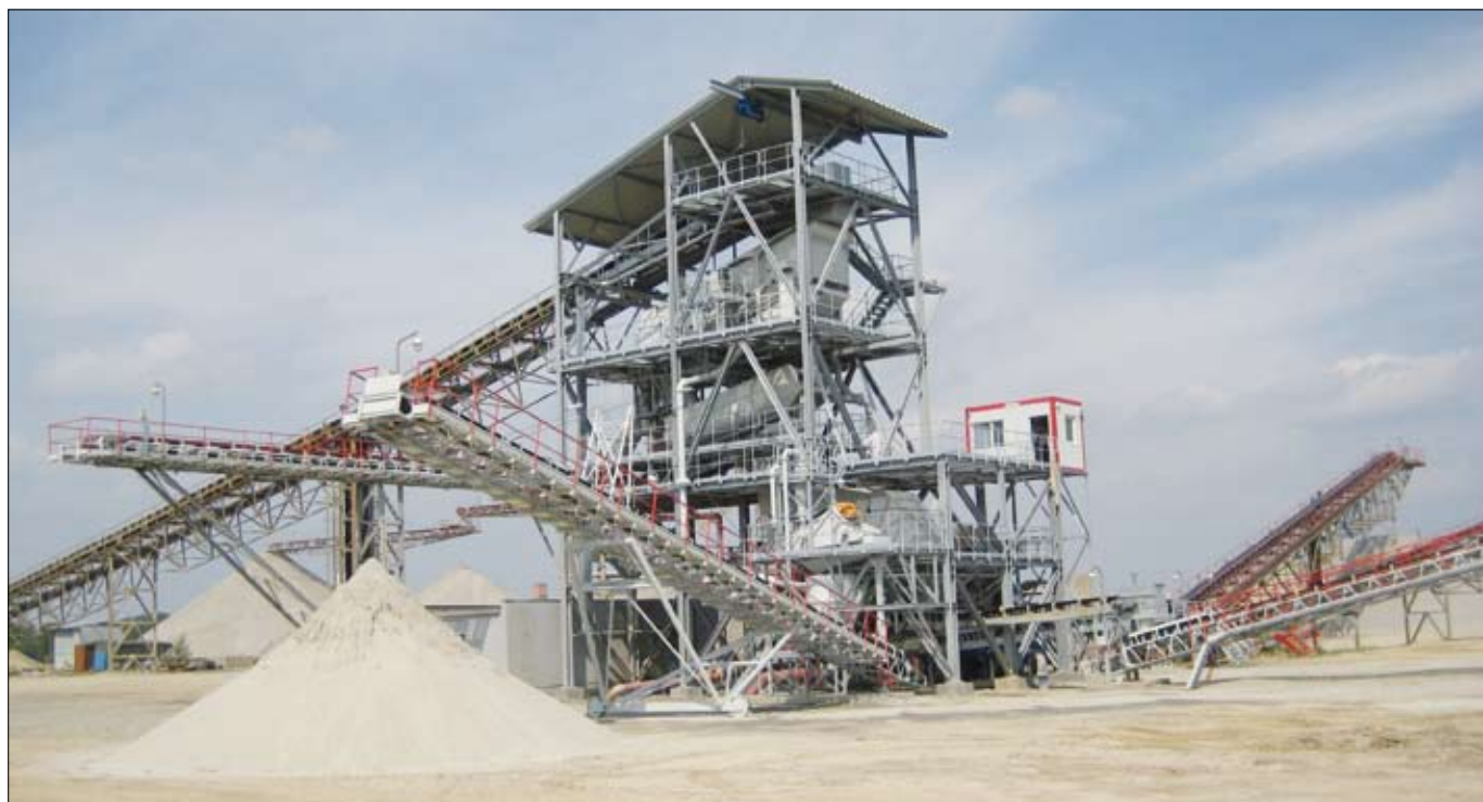
Sand- und Kiesaufbereitungsanlage von ALAS Slovakia in Vysoka
